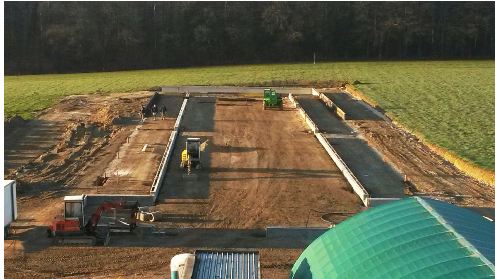
Construction du poulailler pour 12 000 pondeuses à Céligny
